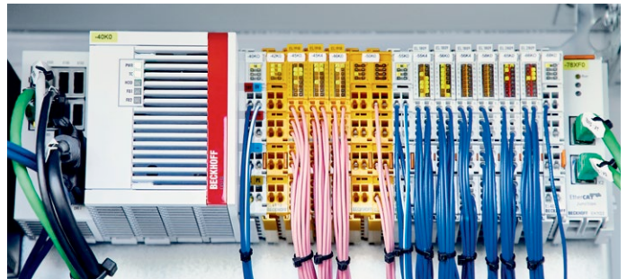
Der Embedded-PC CX5130 und die aus EtherCAT- und TwinSAFE-Klemmen gebildete I/O-Ebene bauen äußerst kompakt.
